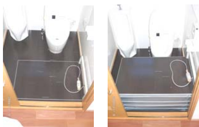
写真9 段差解消機の利用
