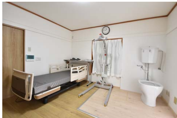
写真10 寝室への汚物流し設置
