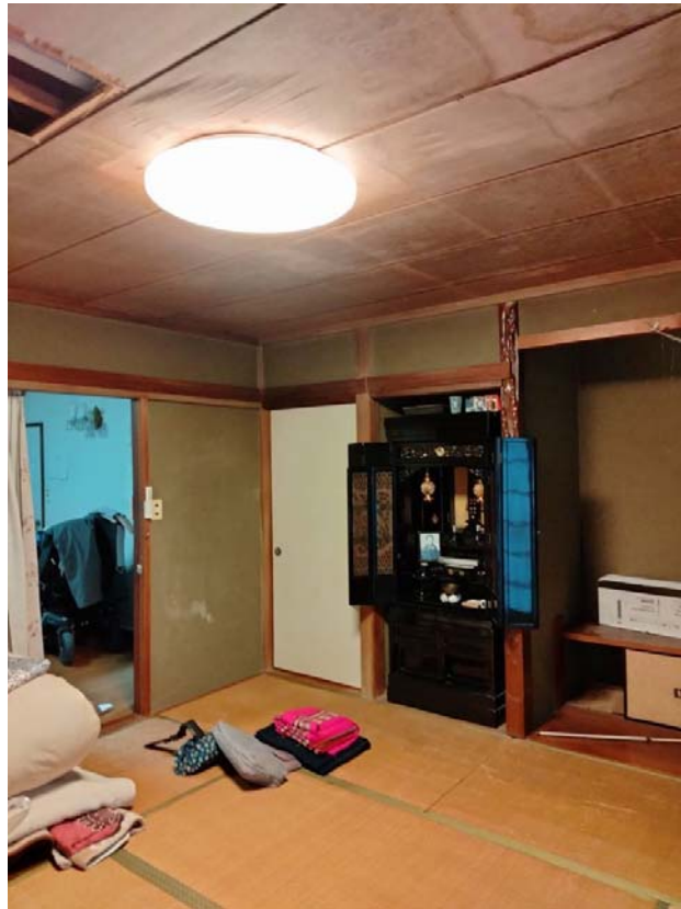
45年経過した和室
