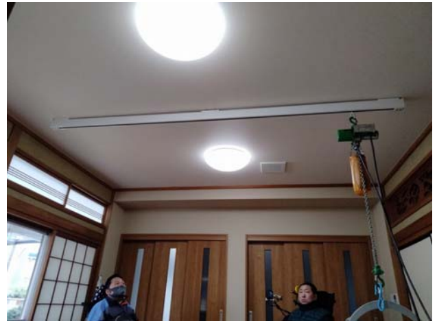
レールは梁に穴を空けて設置しました
